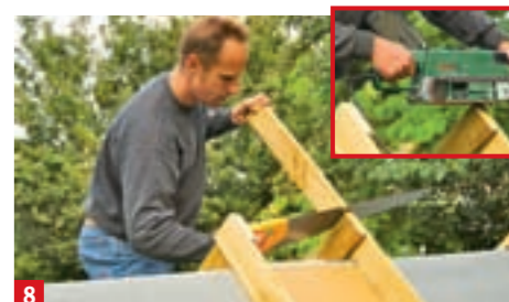
8 Mit der Handsäge kappen Sie die Überstände. Kanten und Spitzen mit dem Bandschleifer runden
