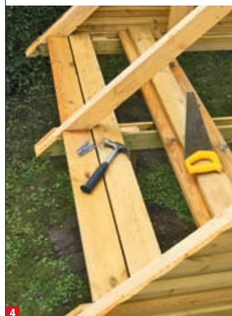
4 Die ersten Bodenbretter zwischen den Sparren auf den Querträgern vernageln. Um überall ...
