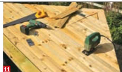
11 ... und 4-x-30-mm-Schrauben montieren. Die Tür ausschneiden und die Beplankung vollenden
