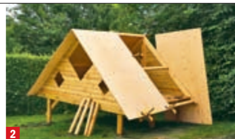
2 ... mit Zwingen fixieren, bevor Sie sie mit 4-x-40-mm-Schrauben montieren. Mit Zwingen fixieren ...
