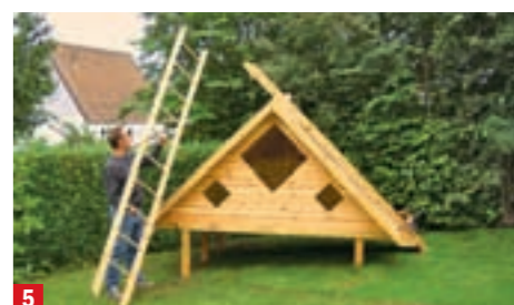
5 Positionieren Sie die Rutsche auf dem Dach. Dort fixieren Sie sie zunächst mit Zwingen
