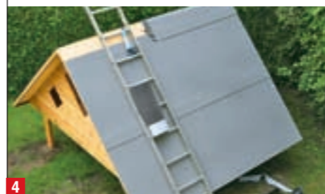
4 Nächste Bahn überlappend aufnageln. Die Überlappung mit Bitumen-Dachdichter versiegeln
