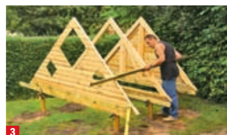
3 Mit Hilfe einer Latte können Sie prüfen, ob das mittlere Element sich in der Flucht befindet
