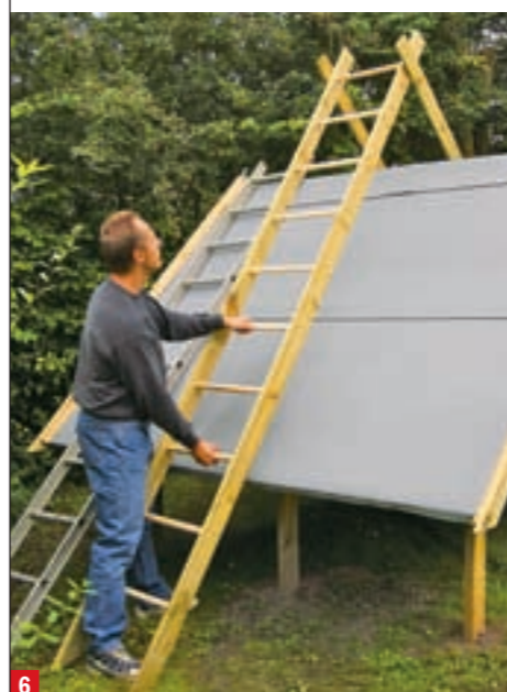
6 Die Leiter platzieren Sie nun zwischen den überstehenden Wangen der Rutsche auf dem Dach
