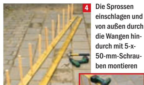
4 Die Sprossen einschlagen und von außen durch die Wangen hindurch mit 5-x-50-mm-Schrauben montieren
