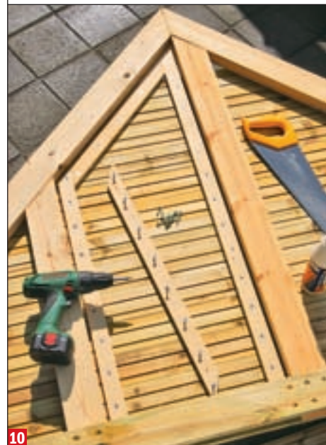
10 Rückseite beplanken bis auf die oberen drei Bretter. Türrahmenleisten mit 10 mm Abstand ...
