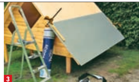
3 ... Sie auch die erste Dachpappebahn. Mit Dachpappenägeln auf der Dachkonstruktion fixieren
