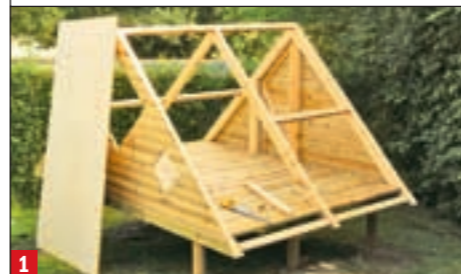
1 Trägerlatten mit 6-x-90-mm-Schrauben oben bündig zwischen den Sparren fixieren. Dachplatten ...
