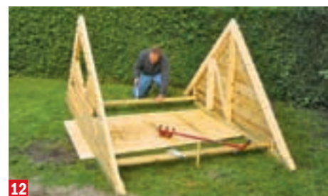
12 Vorder- und Rückgiebel mit Hilfe einer Dachplatte und zweier Bodenbretter parallel ausrichten
